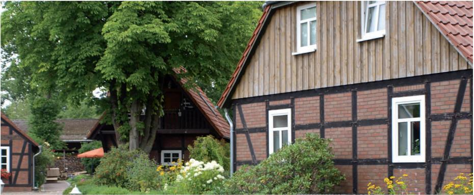
Abb. 11 Typische Giebelabhangung im Obergeschoss
