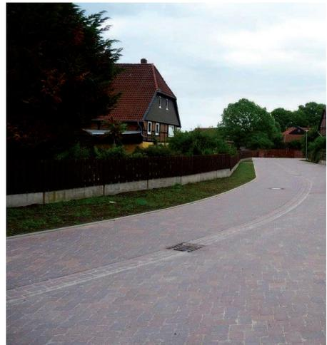
Abb. 16 angepasstes Betonsteinpflaster
