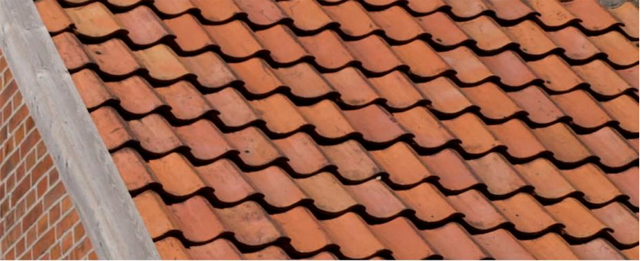
Abb. 2 Dacheindeckung mit Hohlfalzziegeln
