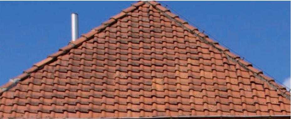
Abb. 3 Verwendung von Linkskrempen
