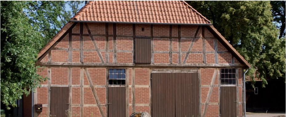
Abb. 9 ausgemauertes Fachwerk
