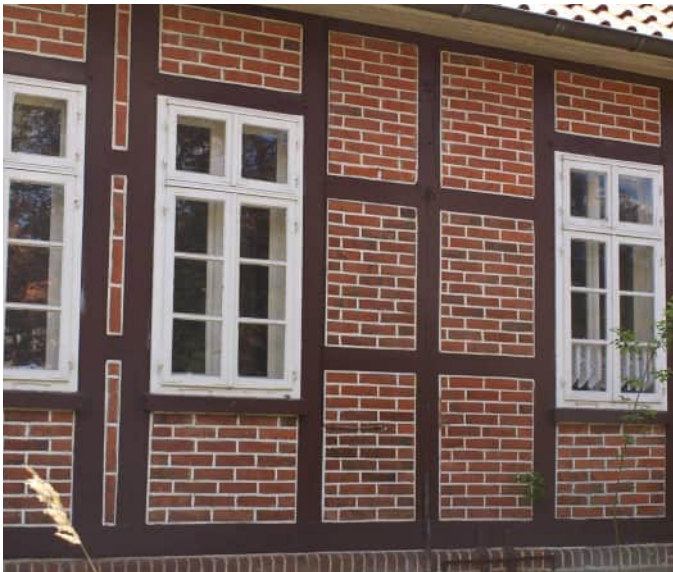
Abb. 15 Doppelte Holzfenster mit Kämpfer
