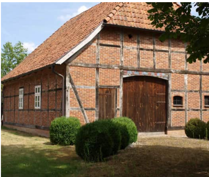
Abb. 4 Fachwerkgebäude mit Krüppelwalmdach
