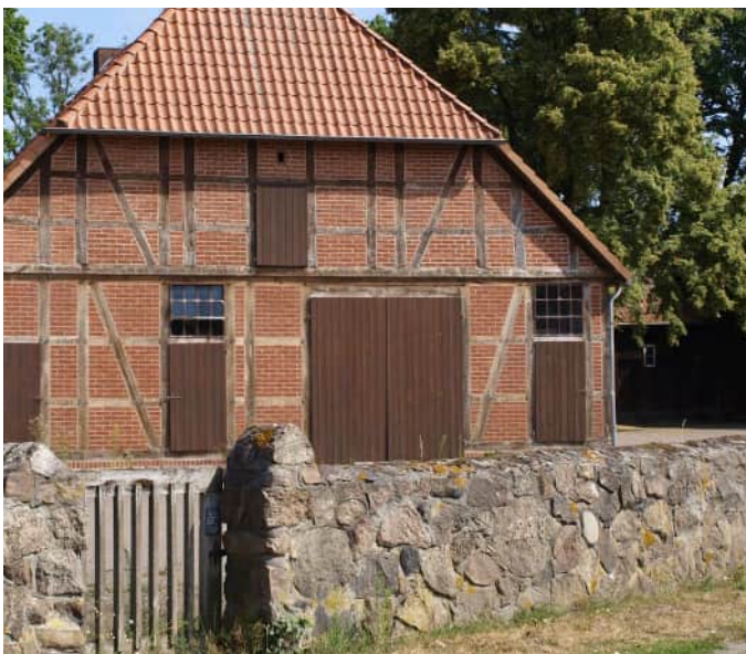
Abb. 9 ausgemauertes Fachwerk
