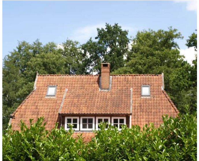
Abb. 5 Dach mit Schleppgaube
