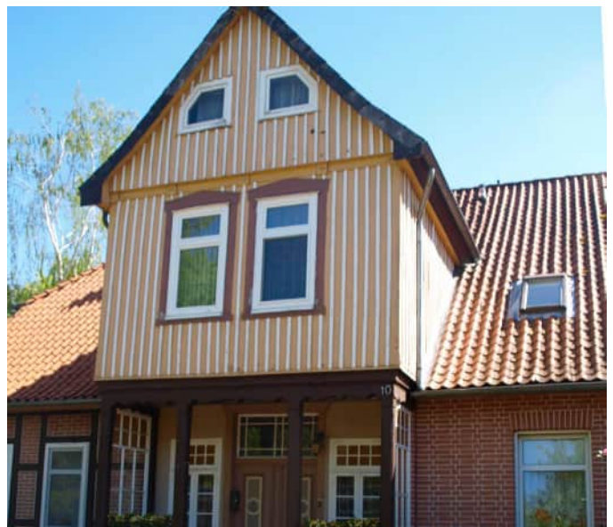
Abb. 12 Zwerchhaus mit Holzverkleidung
