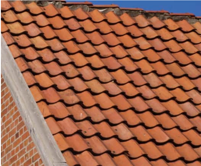
Abb. 2 Dacheindeckung mit Hohlfalzziegeln
