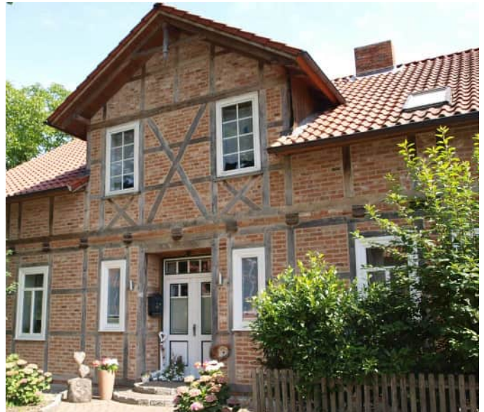
Abb. 6 Gebäude mit Zwerchhaus
