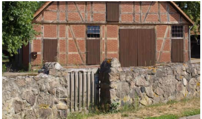
Abb. 22 Einfriedung mit Natursteinmauer und Holzpforte
