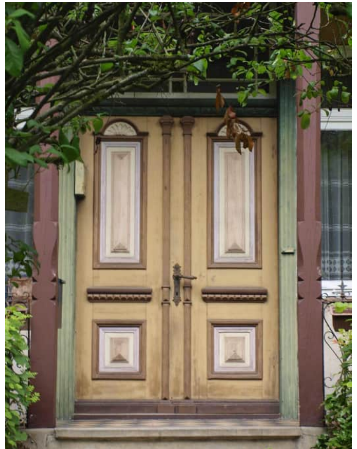
Abb. 17 Gut erhaltene Eingangstür aus Holz
