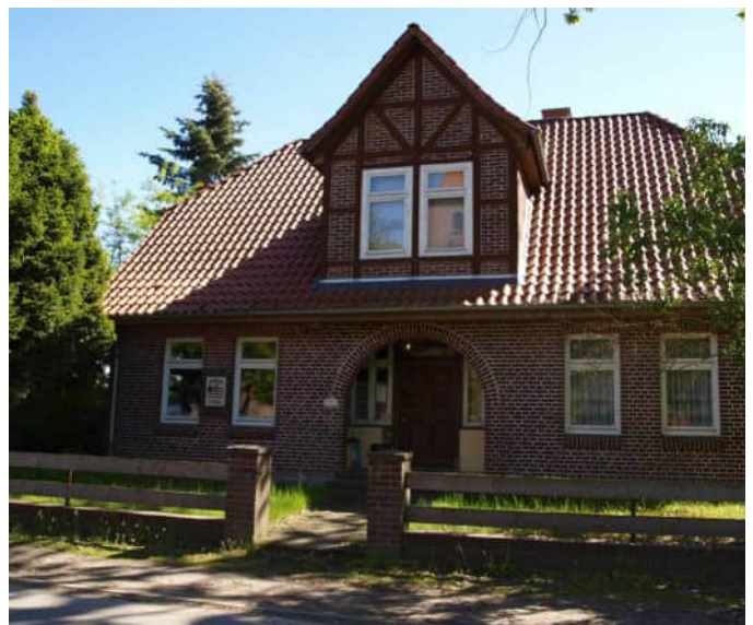
Abb. 7 Dach mit Giebelgaube
