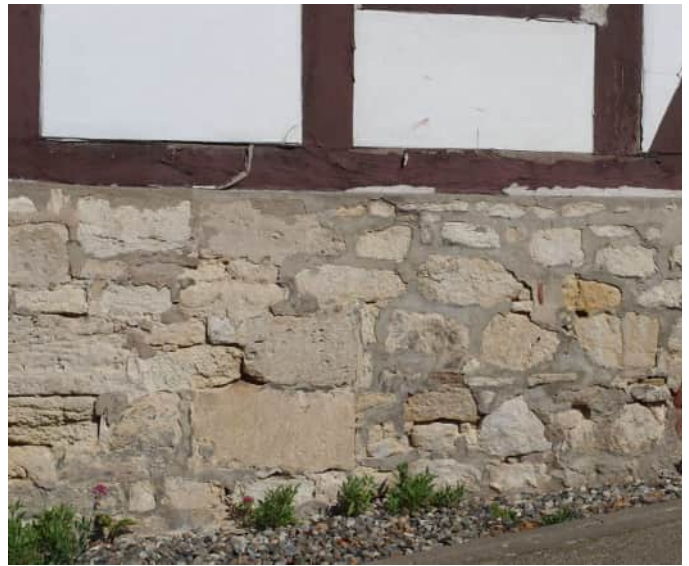
Abb. 11 Natursteinmauerwerk als Sockel unter dem Fachwerk
