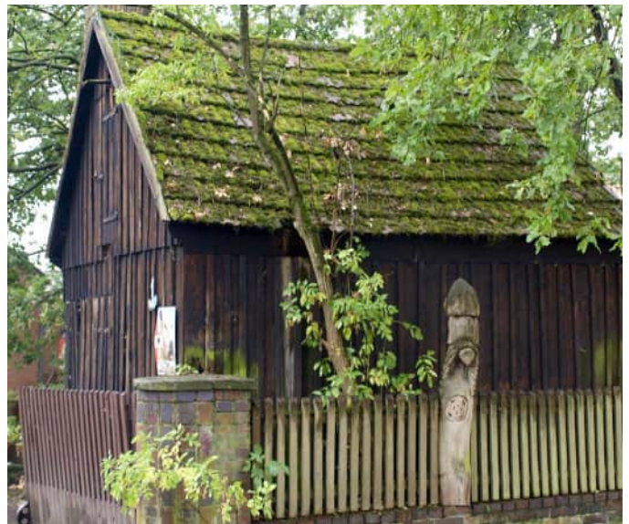
Abb. 13 Nebengebäude mit typischer Boden-Deckelschalung aus Holz
