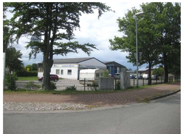
Gewerbegebiet von Osten
