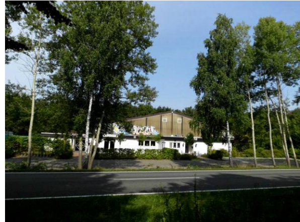
Tennishalle von Südwesten
