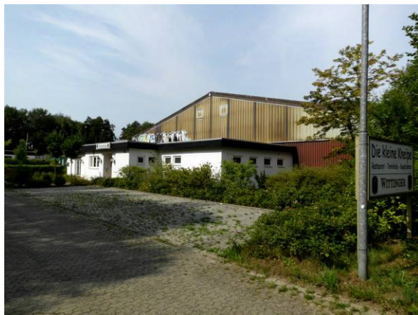
Tennishalle mit Gastronomie u. Parkplätzen aus Südwesten
