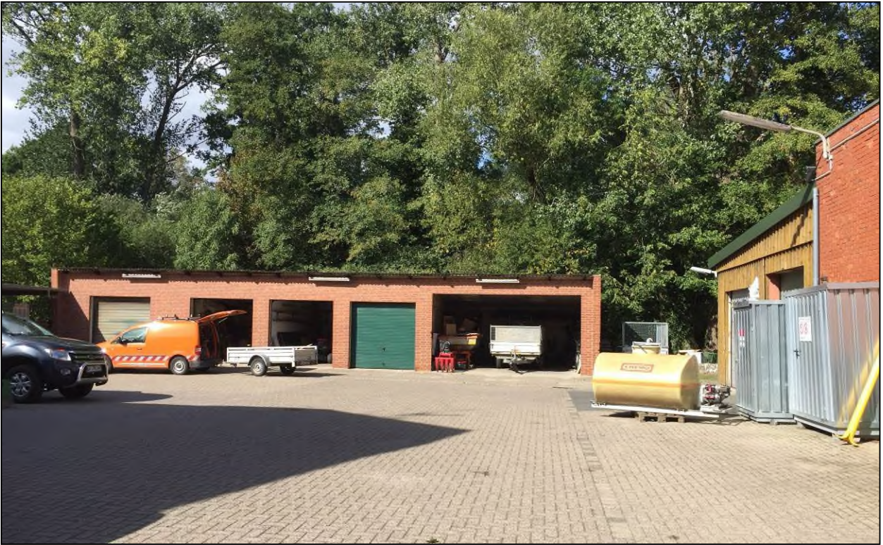
Abb. 10: Werkstatt (Gebäude D).
