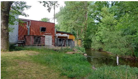
Versorgungsgebäude ehem. Bauhofgelände (Blick Richtung Westen)
