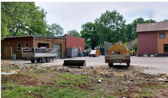
Ehem. Bauhofgelände, Bereich an der Lachte (Blick Richtung Norden)
